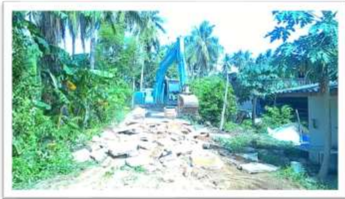
๑๒. ซ่อมสร้างถนน คสล. หมู่ที่ ๓ บ้านหัวเข้
