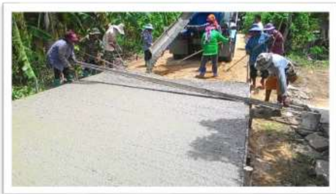
๑๓. ก่อสร้างประปาหมู่บ้านขนาดใหญ่ หมู่ที่ ๕ บ้านโนดง
